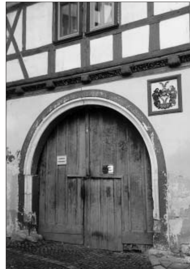
UNSER BILD: Im äußeren Bereich der Innenstadt gelegen, verspricht auch das Gebäude Schmiedhof Nr. 19 a – das „Stengelsche Haus“ – ein höchst attraktiver Blickfang zu werden. Im Innern schon vollständig modernisiert, werden die Handwerker erneut bestellt, wenn die beantragten Fördergelder zur Sanierung der Außenfassade genehmigt sind.
