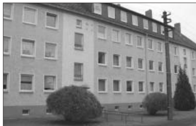
Renthofstraße 64–70: Das Prinzip, einzelne Wohnanlagen nach vorhandener Liquidität zu reparieren und instand zu setzen, betraf in 2001 neben der Fenstererneuerung an diesem Gebäude auch zwei Häuser im Hedwigsweg 44–46 und 48–50. ▶▶▶ In der Straße der Einheit von Mittelstille sowie an weiteren Einzelobjekten führten Dachdeckerfirmen wichtige Instandhaltungsarbeiten aus.
