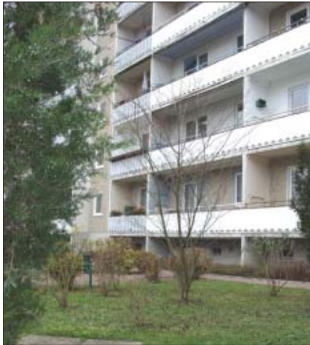
◀◀ Im Martin-Luther-Ring 31–37 wurde im Jahr 2005 mit der Teilsanierung für insgesamt 60 Wohneinheiten begonnen.
