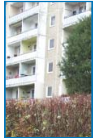
«»» Nach Sanierungsmaßnahme: Die 60 Wohneinheiten im M.-Luther-Ring 31–37 sollen langfristig erhalten bleiben.
