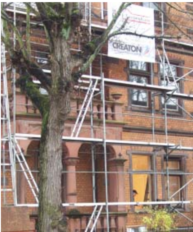
◀◀◀ In Schmalkaldens Geschwister-Scholl-Straße 6 werden das Gebäude und drei Wohneinheiten teilsaniert.
