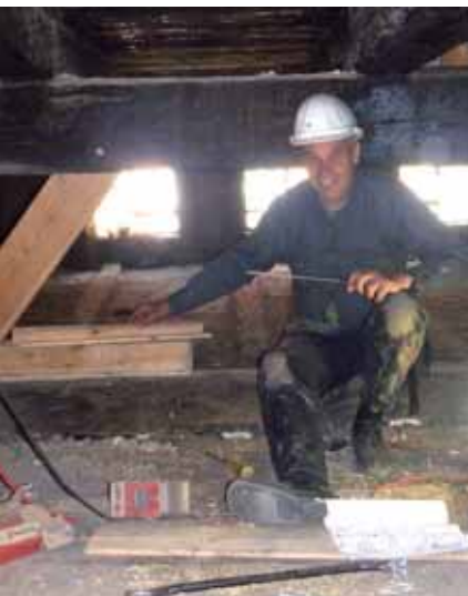
■ BILD: Stein auf Stein – die Unterfahrung der Fachwerkwände mit neuen Fundamenten verleiht dem Baukörper Stabilität. ■ BILD LINKS: Die zimmermannsmäßige Reparatur des Unterzuges im Kriechboden geht einher mit der Ausmauerung der rekonstruierten Fachwerkwände unter Verwendung von Lehmsteinen nach historischem Vorbild
